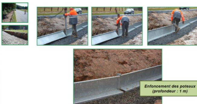
Etape 2 – Installation des profils
