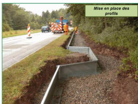
Etape 2 – Installation des profils
