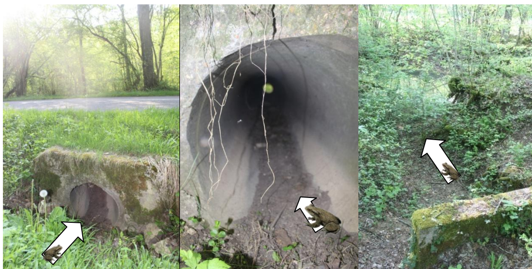
Figure 22 Buse du secteur 3 de la zone forte mortalité routière des crapauds communs du Val-Suzon. 11 m de longueur et 50 cm de diamètre. (les flèches indiquent le sens de migration prénuptiale vers le Suzon). À noter la présence de litière dans le fond de la buse, favorable au passage des grenouilles et urodèles © DB
